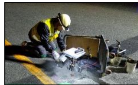
滑走路状態表示灯(RWSL)の 工事開始(羽田空港 R6.10.1~)
