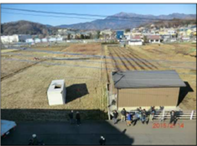
⑥ 横転したコンテナ(南に約7m移動) 【東から撮影】
