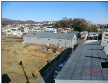
① 屋根の一部が飛散した倉庫 【南から撮影】
